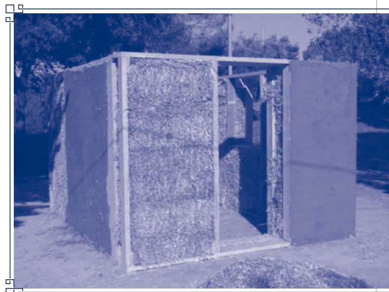
Struttura dimostrativa in balle di paglia costruita in occasione del Conero Ecofestival, settembre 2012.
